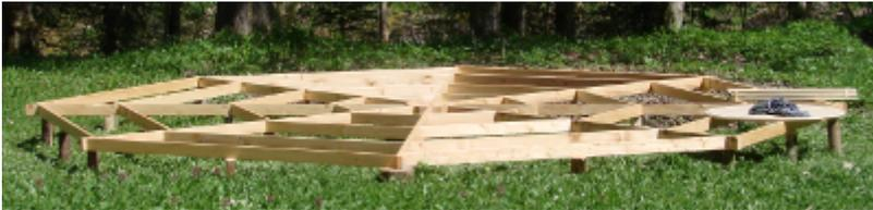
Bei einem Isolierten Boden werden die Isolationskästen in die Unterkonstruktion reingelegt.
